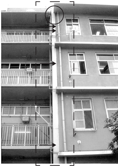
写真1 修道学園の校舎。 左が教室で右が科学棟。このつぎ目にコロニーがある。 ○印部分が出入り口で、入るのはこの部分だけ。出口（→の所）は何力所もある。
