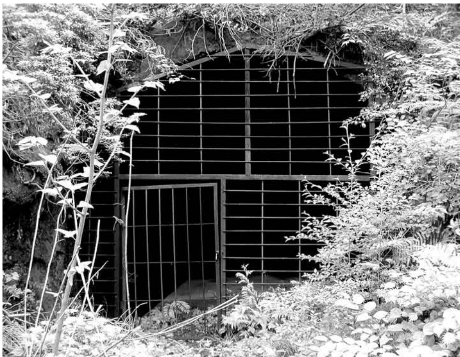
図1 バットゲート（三重県亀山市の地下壕）
